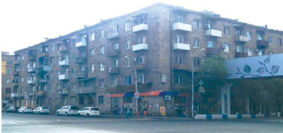
Рис. 1. Общий вид здания
