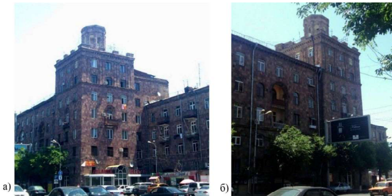
Рис. 1. Общий вид здания
