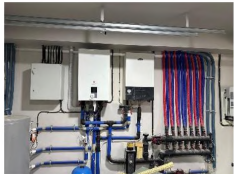
Նկ.4. Առանձնատան ջերմապոմպային տեղակայանքով ջեռուցման համակարգ
