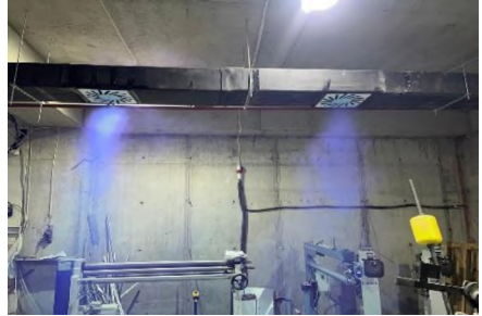
Նկ.12 Օդի հոսքի պատկեր մրրկային դիֆուզորի կիրառմամբ
