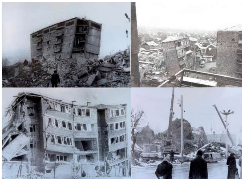
Рисунок 16. Фотодокументальные материалы катастрофических разрушений жилой и инженерной застройки города Гюмри при Спитакском землетрясении 7 декабря 1988 г. ( M_w = 6,8 ).
